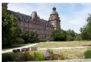
Asch.V, Blick von der Neuen Gartenanlage auf das Schloss, DI026854, BSV
