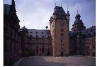
Asch.I, Innenhof mit Bergfried, DE003867, BSV-
