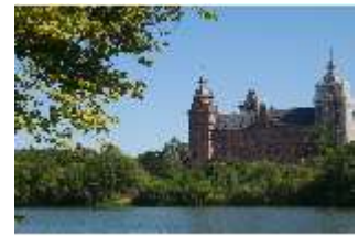
Asch.I, Südfassade, DI013980, BSV-
