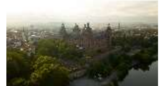
Asch.I, Luftaufnahme von W, DI024569, BSV-
