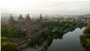
Asch.I, Luftaufnahme von W, DI024570, BSV-
