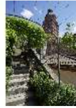
Asch.V, Kapuzinergang über Teilen der alten Stadtmauer, DI026866, BSV
