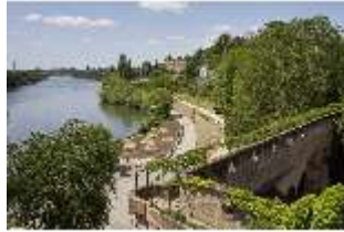
Asch.V, Kapuzinergang über Teilen der alten Stadtmauer, DI026868, BSV
