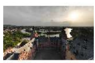
Asch.I, Luftaufnahme von NO, DI024582, BSV-
