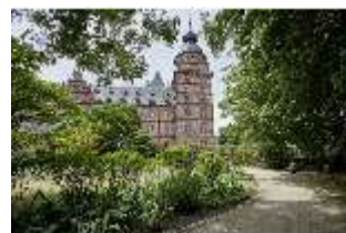
Asch.V, Blick von der Neuen Gartenanlage auf das Schloss, DI026861, BSV
