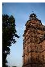
Asch.I, Eckturm von außerhalb des Schlosses, DI024639, BSV-
