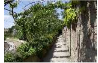
Asch.V, Kapuzinergang über Teilen der alten Stadtmauer, DI026870, BSV
