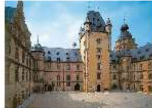
Asch.I, Innenhof mit Bergfried, DE001181, BSV-
