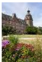
Asch.V, Blick von der Neuen Gartenanlage auf das Schloss, DI026853, BSV
