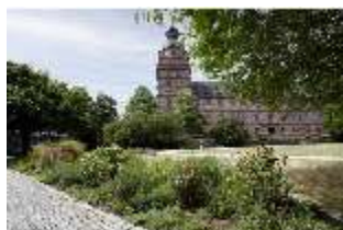
Asch.V, Blick von der Neuen Gartenanlage auf das Schloss, DI026857, BSV
